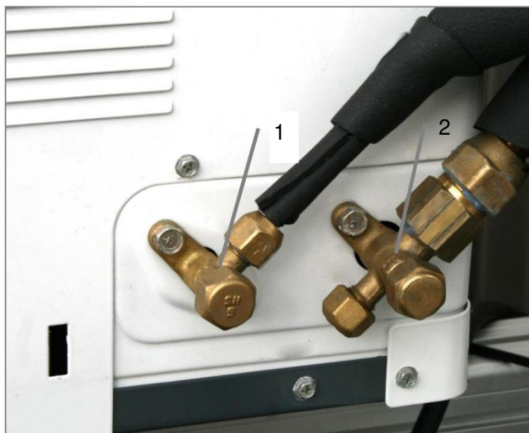
Afbeelding 11: Koelleidingaansluitingen (flare-aansluitingen) buitenunit
